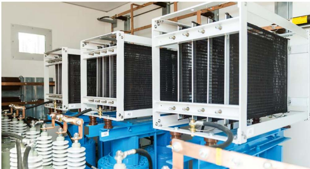
Innenansicht der Filterkreisstation. Sie sorgt für saubere Netze im Frequenzbereich bis 9 kHz – die erste Hochfrequenzfilteranlage in einem Windpark, realisiert als Turn-Key-Projekt von den Power Quality-Experten der Maschinenfabrik Reinhausen (MR).
